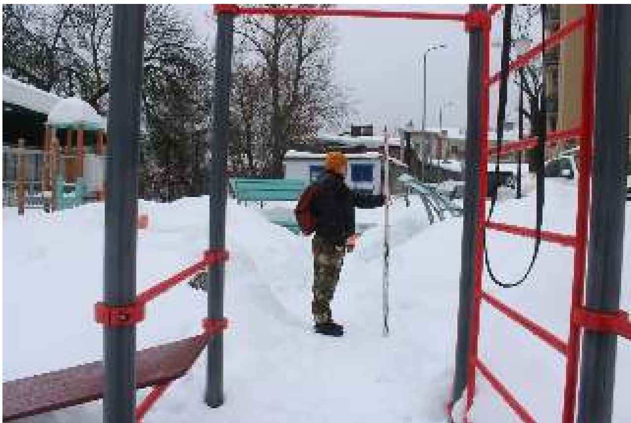
Илл.22. Общий вид земельных участков, отведенного для расположения объекта: Квартальная теплотрасса отопления от НТЦ, 2 очередь (УТ-245-3 кла) инв. 97701. Участок работ: от ТК-245-3 к 1-36(нов.) у д.18а по ул. Большая Покровская до т. в 20м на СВ от С угла д.18а по ул. Большая Покровская на границе ЗУ 52:18:0060061:7. Точка фотофиксации 1. Вид с севера.
