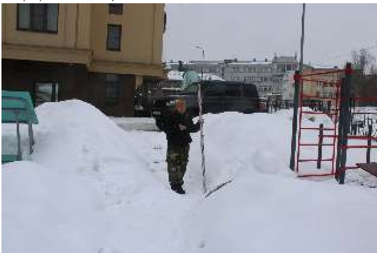
Илл. 23. Общий вид земельных участков, отведенного для расположения объекта:Квартальная теплотрасса отопления от НТЦ, 2 очередь (УТ-245-3 кла) инв. 97701. Участок работ: от ТК-245-3 к 1-36(нов.) у д.18а по ул. Большая Покровская до т. в 20м на СВ от С угла д.18а по ул. Большая Покровская на границе ЗУ 52:18:0060061:7. Точка фотофиксации 1. Вид с востока.
