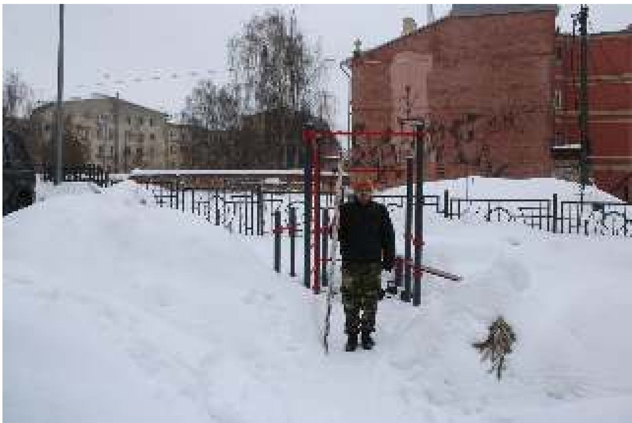
Илл. 20. Общий вид земельных участков, отведенного для расположения объекта: Квартальная теплотрасса отопления от НТЦ, 2 очередь (УТ-245-3 кла) инв. 97701. Участок работ: от ТК-245-3 к 1-36(нов.) у д.18а по ул. Большая Покровская до т. в 20м на СВ от С угла д.18а по ул. Большая Покровская на границе ЗУ 52:18:0060061:7. Точка фотофиксации 1. Вид с юга.
