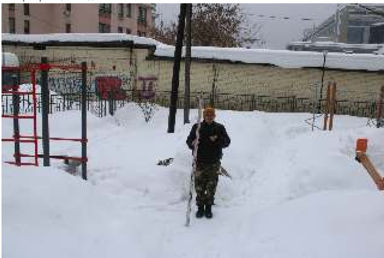
Илл.21. Общий вид земельных участков, отведенного для расположения объекта: Квартальная теплотрасса отопления от НТЦ, 2 очередь (УТ-245-3 кла) инв. 97701. Участок работ: от ТК-245-3 к 1-36(нов.) у д.18а по ул. Большая Покровская до т. в 20м на СВ от С угла д.18а по ул. Большая Покровская на границе ЗУ 52:18:0060061:7. Точка фотофиксации 1. Вид с запада.
